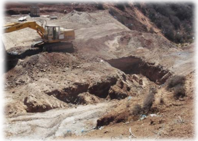
Photo 6 : Travaux de terrassement « Déblai pour fouilles »
