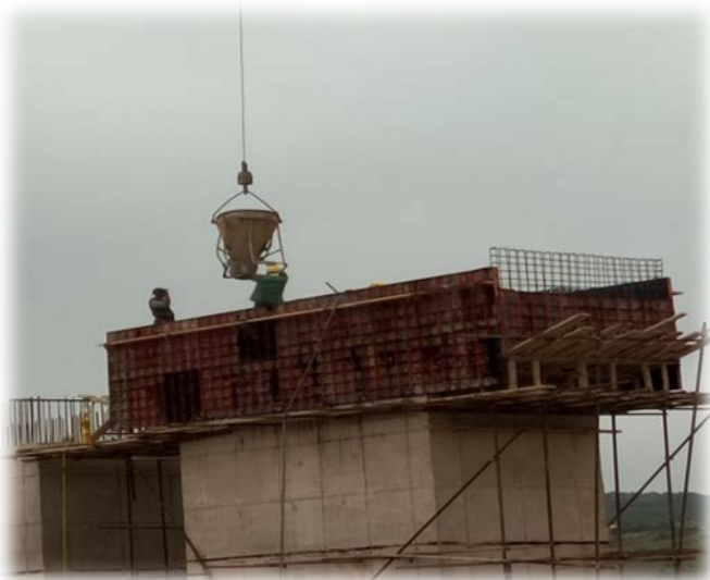
Photo 38 : Mode opératoire de bétonnage
