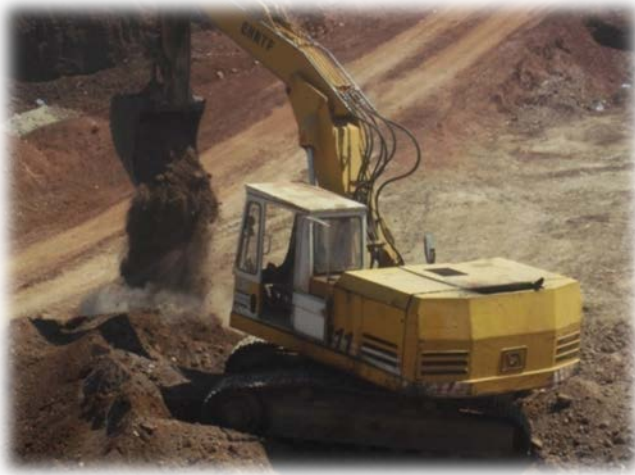
Photo 5 : Travaux de terrassement « Déblai pour fouilles »
