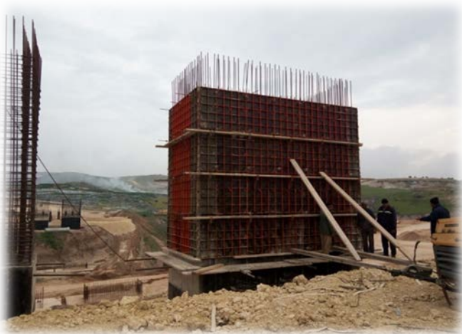
Photo 16 : Ferrailage et coffrage des piles
