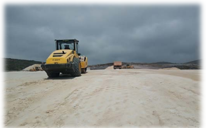
Photo10 : Travaux de terrassement « remblais »
