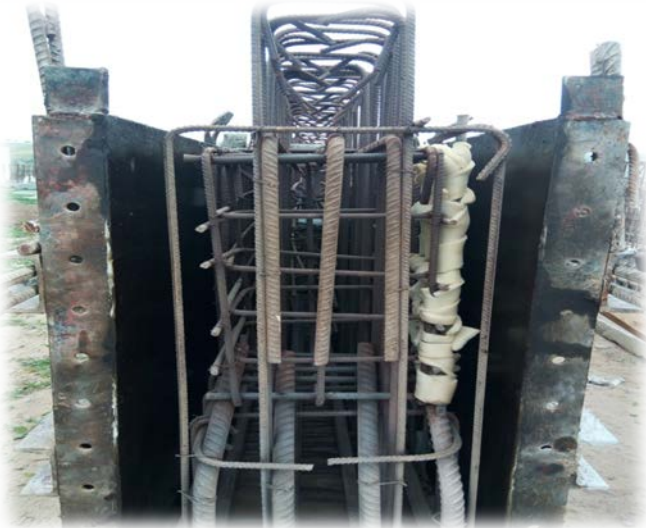
Photo 46 : coffrage des poutres en béton armé
