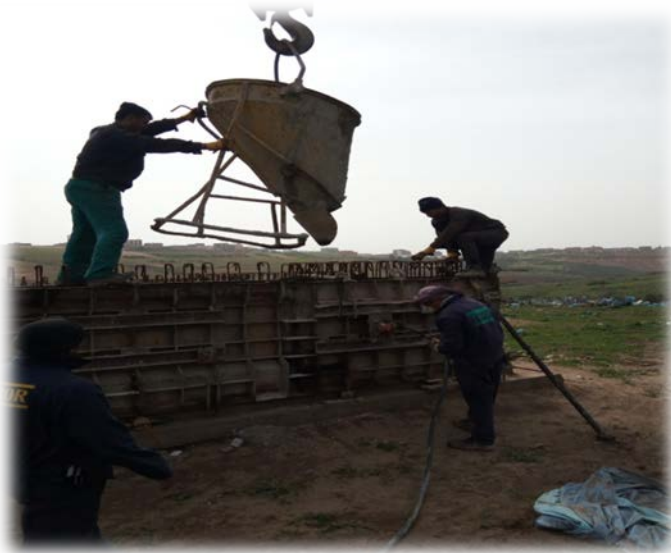
Photo 52 : Mode opératoire de bétonnage des poutres
