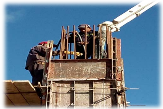
Photo 33 : Bétonnage des murs contreforts culée 2
