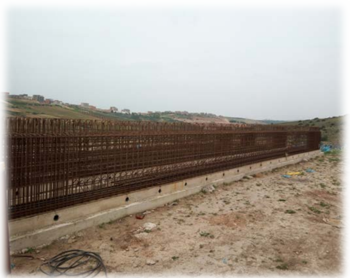
Photo 49 : Ferrailage des poutres en béton armé
