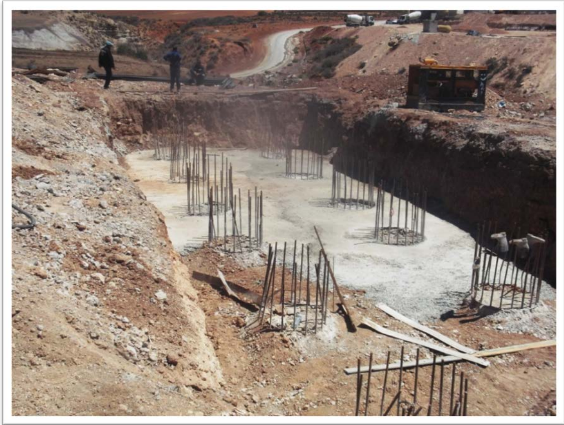
Photo 11 : Têtes des pieux après recépage.
