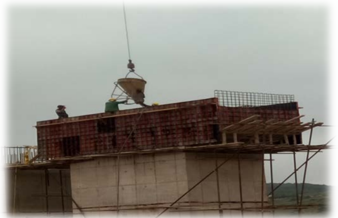
Photo 37 : coffrage et Bétonnage des chevêtres
