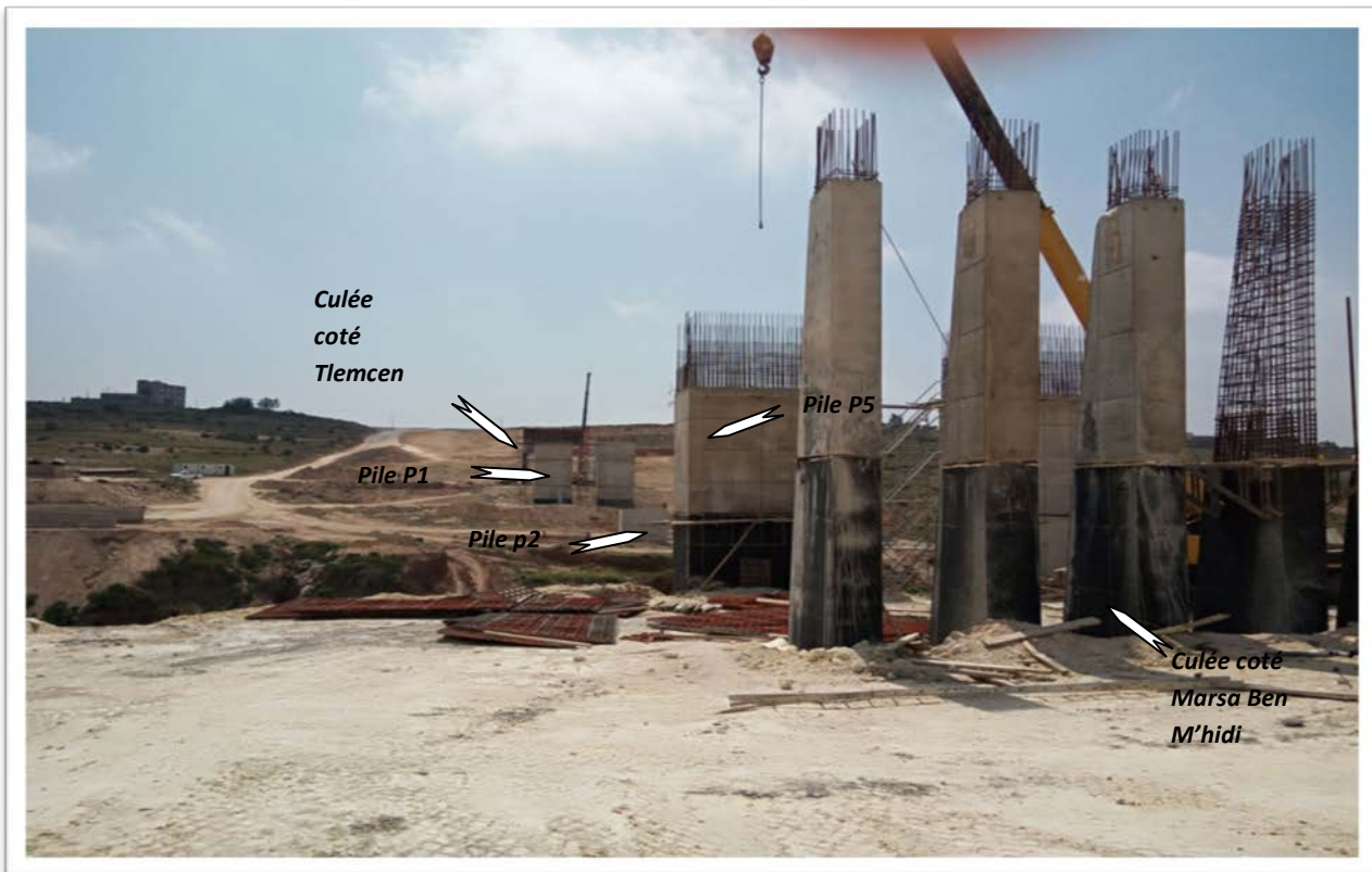
Photo 4 : Vue d'ensemble de l'ouvrage.
