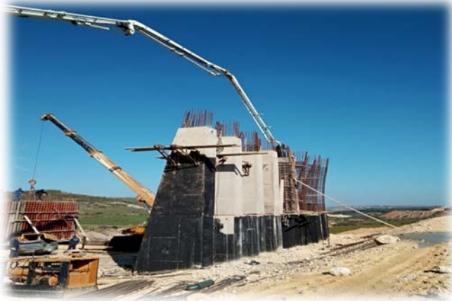
Photo 32 : Bétonnage des murs contre forts culée 2
