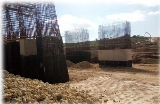
Photo9 : Travaux de terrassement « remblais »
