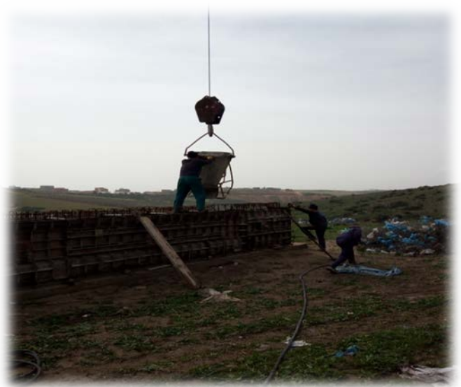
Photo 53 : Mode opératoire de bétonnage des poutres
