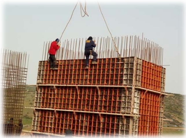
Photo 20 : Décoffrage des piles.
