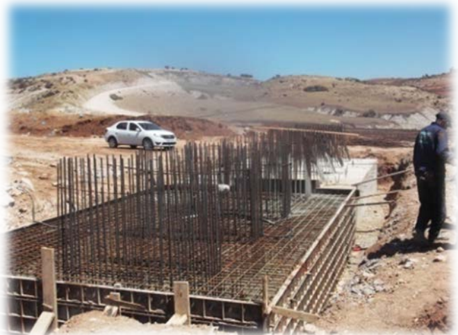
Photo 13 : Ferrailage et coffrage de la Semelle.
