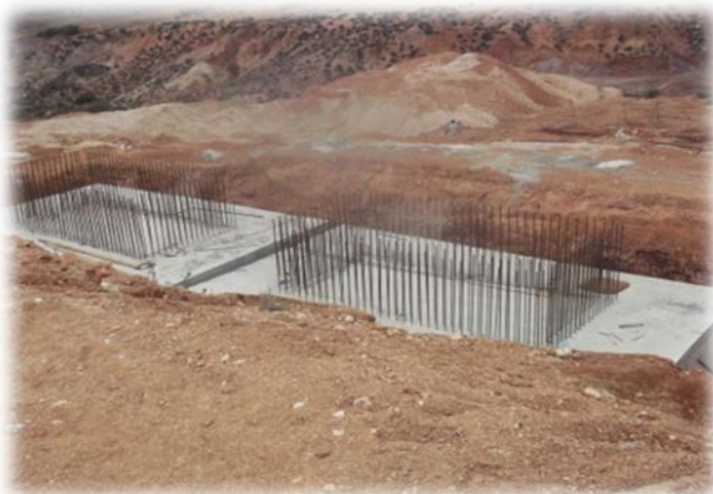
Photo 14 : Semelle de la pile achevée.
