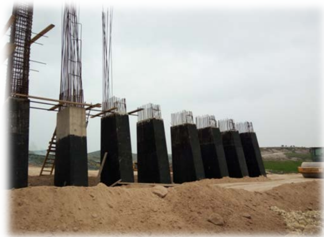
Photo 28 : Ferrailage des murs contreforts
