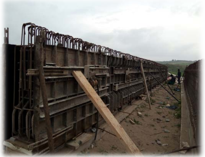
Photo 47 : coffrage des poutres en béton armé
