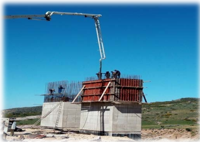
Photo 22 : Mode opératoire de bétonnage des piles
