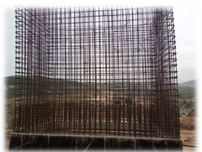
Photo 19 : Ferrailage des piles.
