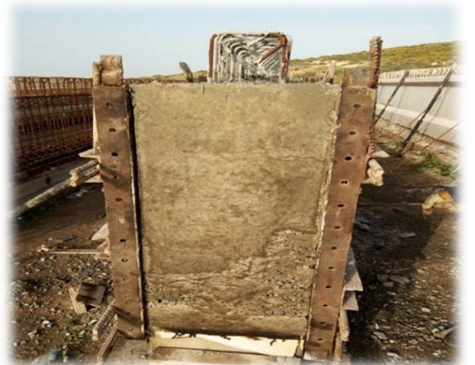
Photo 51 : Décoffrage des poutres en béton armé
