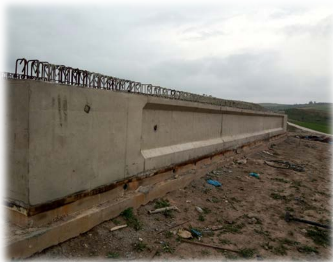
Photo 50 : Poutre en béton armé
