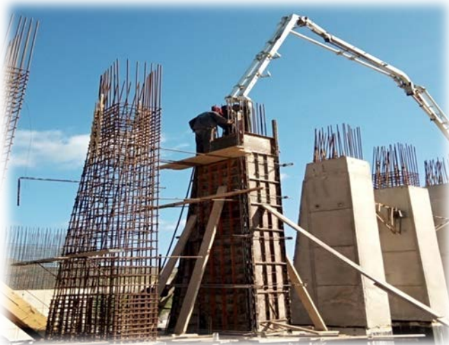
Photo 34 : Bétonnage des murs contreforts culée 1 levée
