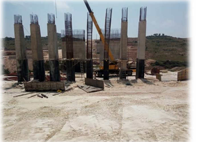
Photo 31 : Ferrailage des murs contreforts culée 2 levée
