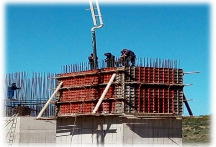
Photo 23 : Mode opératoire de bétonnage des piles
