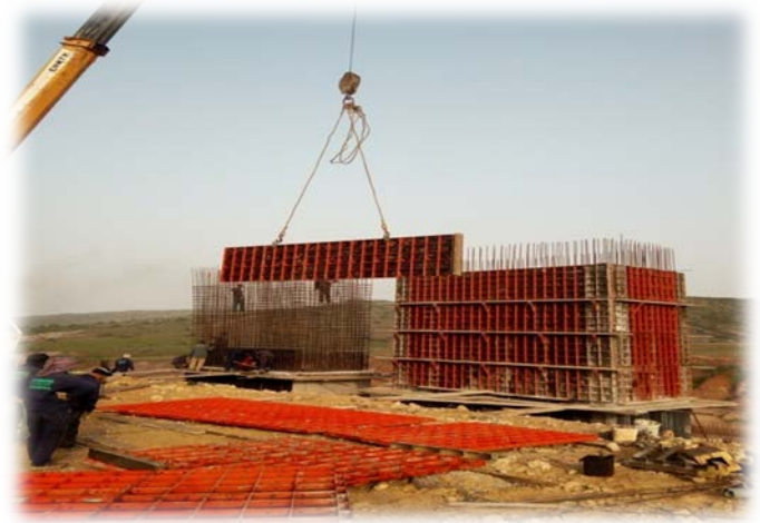
Photo 21 : Décoffrage des piles.
