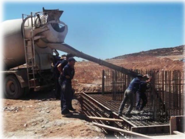
Photo 12 : Bétonnage de la Semelle.
