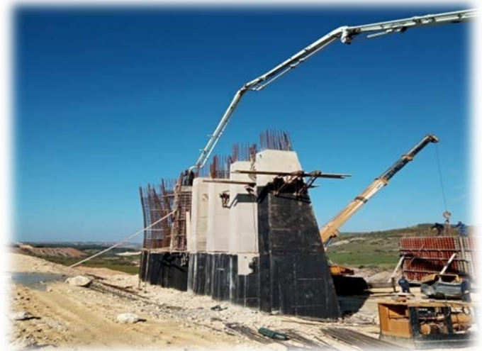
Photo 35 : Bétonnage des murs contreforts culée 1 levée
