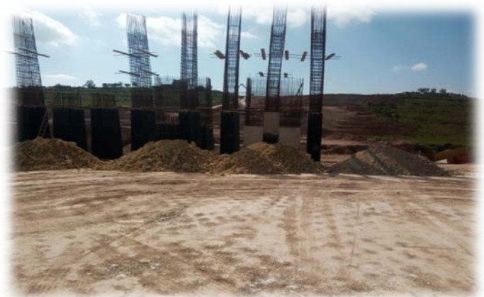
Photo 8 : Travaux de terrassement « remblais »
