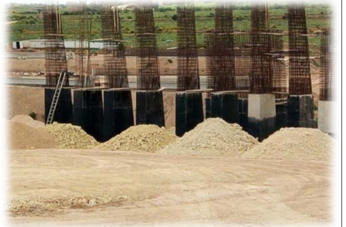
Photo 29 : Ferrailage des murs contreforts culée 2
