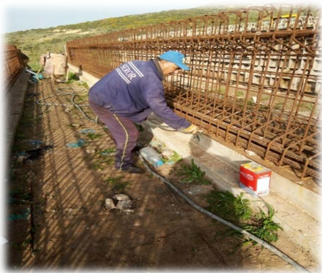
Photo 48 : Opération de sablage des armatures
