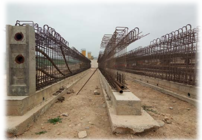
Photo 45 : Ferrailage de poutres en béton précontraintes.
