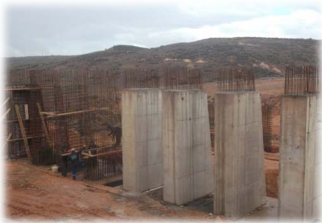
Photo 26 : Ferrailage et bétonnage des murs contreforts culée ½ levée
