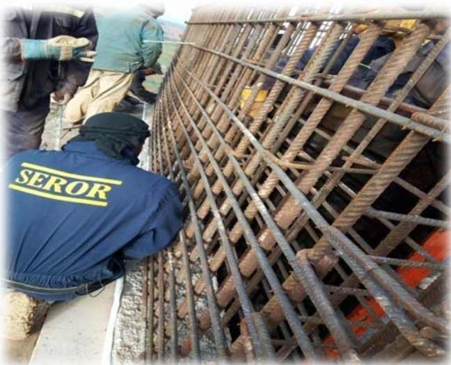
Photo 18 : Ferrailage des piles.
