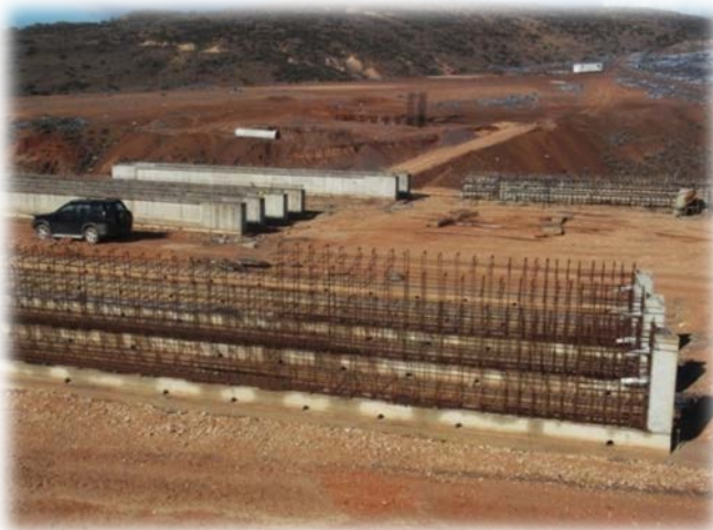
Photo 44 ; Ferrailage des poutres en béton armé de 20 m
