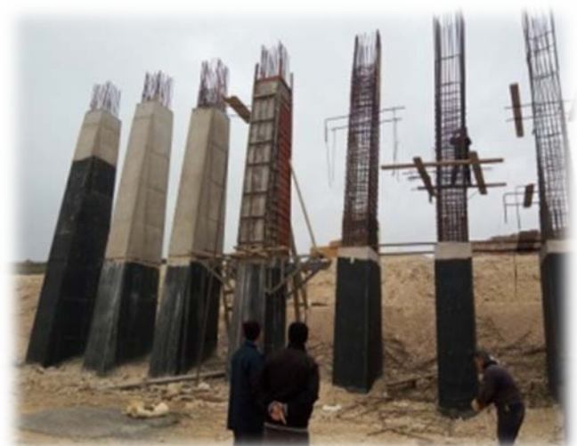
Photo 30 : Ferrailage et coffrage des murs contreforts culée 2 levée
