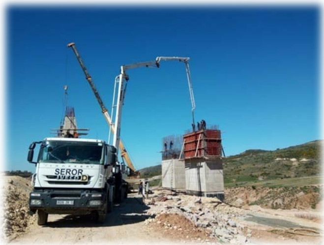
Photo 24 : Mode opératoire de bétonnage des piles
