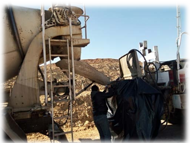
Photo 25 : Mode opératoire de bétonnage des piles
