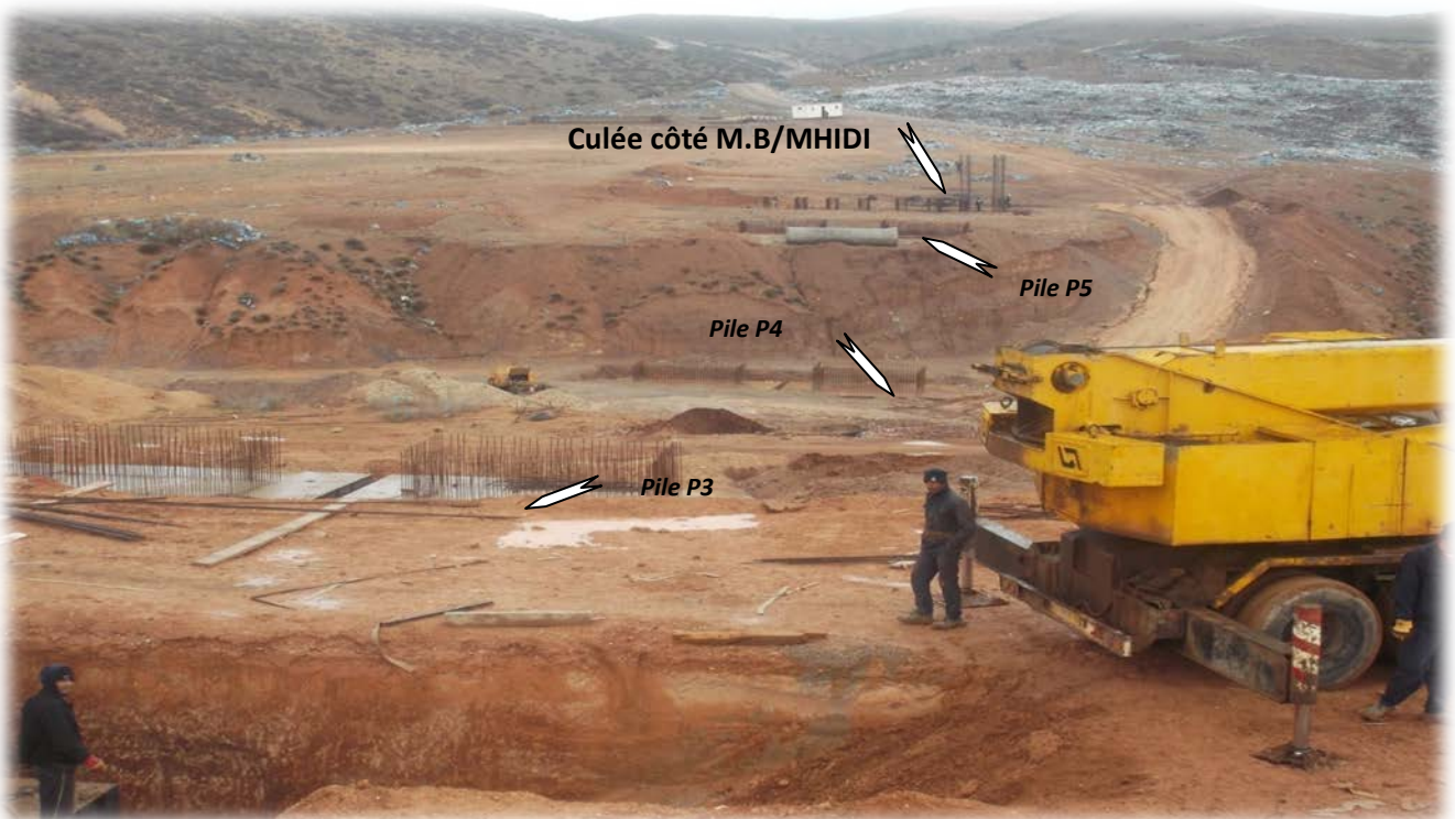
Photo 2 : Vue d'ensemble de l'ouvrage.
