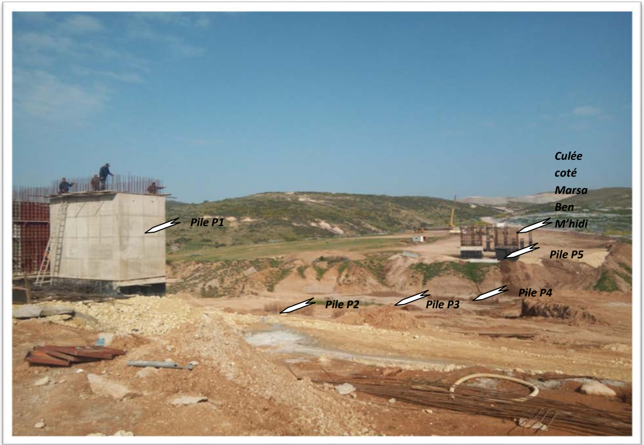
Photo 3 : Vue d'ensemble de l'ouvrage.
