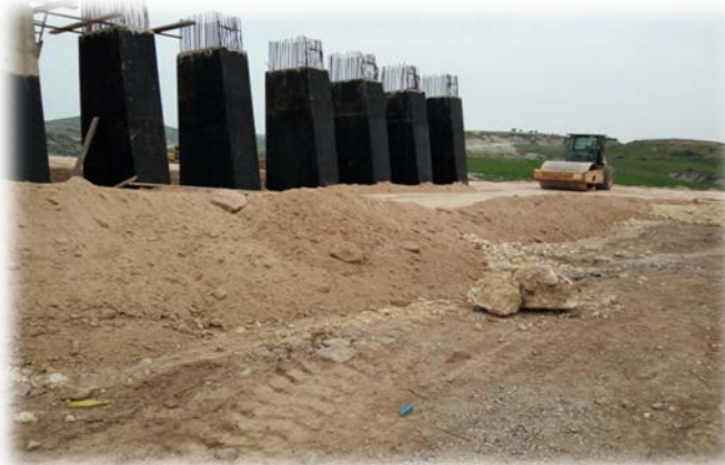
Photo 7 : Travaux de terrassement « remblais »
