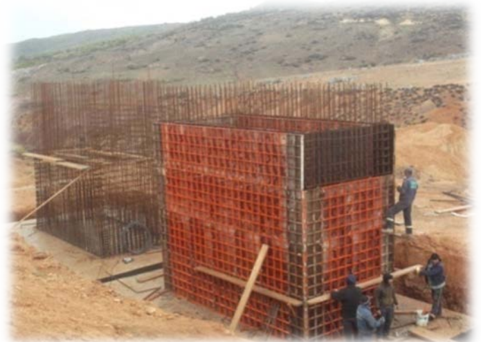
Photo 17 : Ferrailage et coffrage des piles
