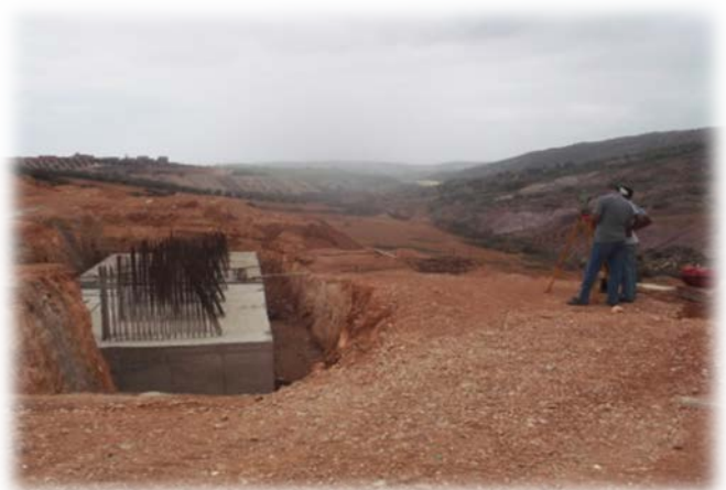
Photo 15 : Semelle de la culée achevée.
