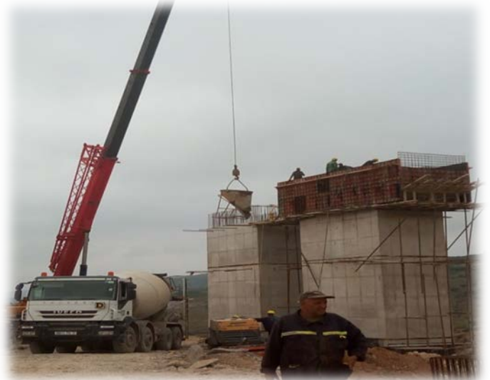
Photo 39 : Mode opératoire de bétonnage
